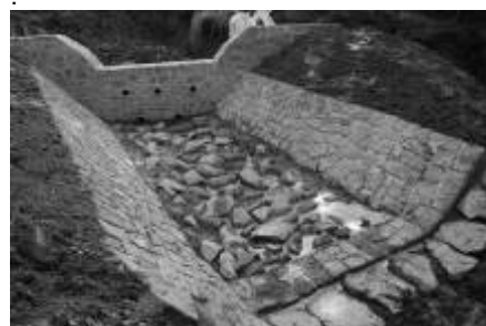
Obrázek 6: ukázka přehrážky se zdrsněným spadištěm.
