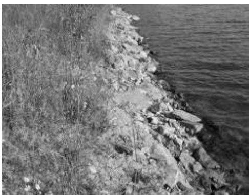
Fig. 2: Passive stabilization, Brno reservoir, „SOKOLSKÉ KOUPALIŠTĚ“ area, foto M.Šlezinger, 2012
